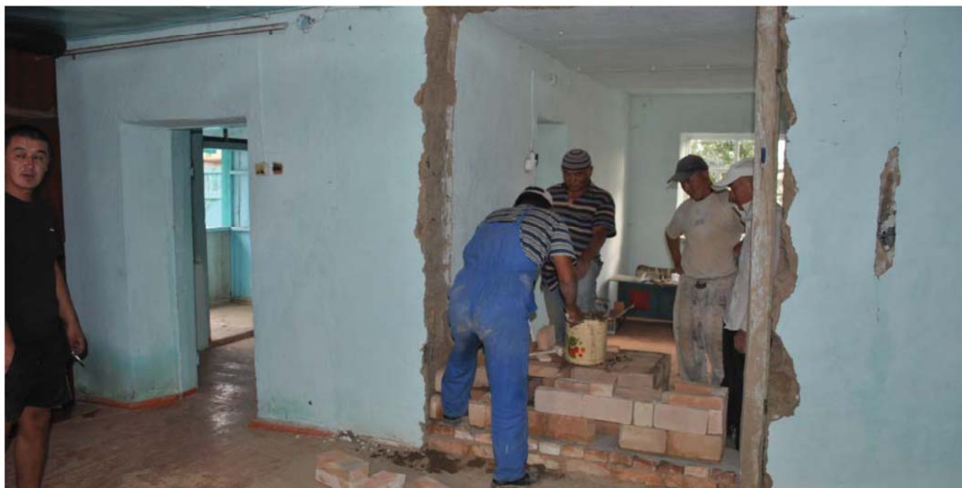
Строительство энергоэффективной печи Energy efficient stove construction
