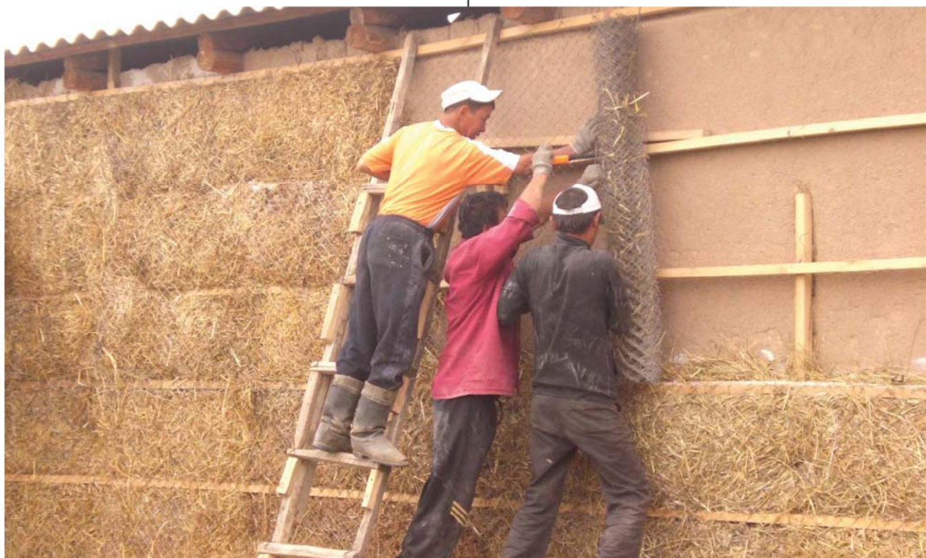
Теплоизоляция дома с применением органических материалов House heat insulation with organic materials
